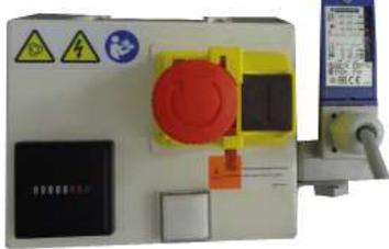
Coffret électrique de base LG7 avec pressostat mécanique pour contrôler la centrale de vide LABOVAC 1.
